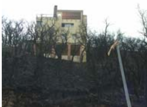
Fig 2 y 3. Vivienda quemando y vivienda con todo su alrededor quemado momentos después del paso del fuego en Santa Cristina d'Aro (29/08/03). Hay que destacar que las viviendas no queman al paso del frente, sino que entran en ignición en este momento y queman posteriormente.
